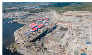
Центр строительства крупнотоннажных морских сооружений (Кольская верфь)
